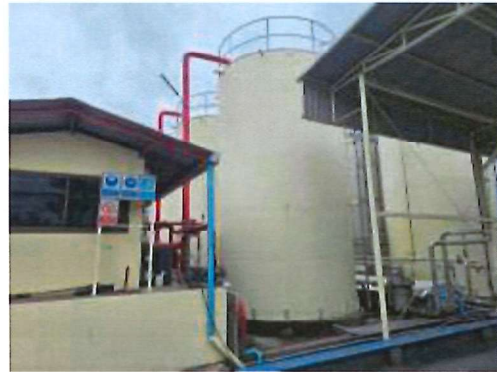
ภาพที่ 8 ถังเก็บกักน้ำขนาด 170 ลบ.ม.
